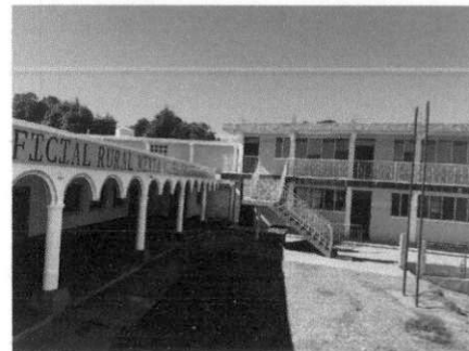
Foto 6 Pintura de muros exteriores e interiores
