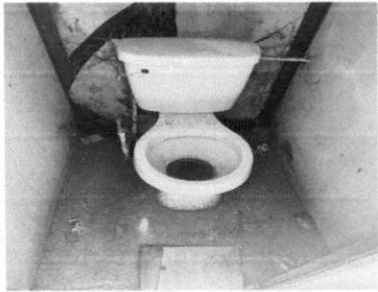
Foto 7: Sustitución de Sanitarios
