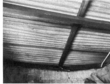
Foto 2: sustitución de estructura de madera por metal
