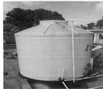
Foto 10: Sustitución de Rotoplas.
